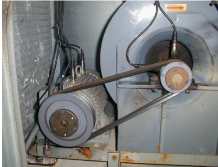
Figura 3: Detalle de montaje en motor
